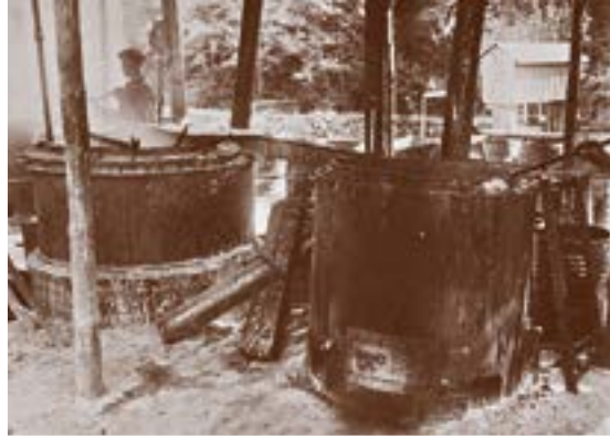
Abbildung 16: Erhitzung des Bindemittels mit Teerkochern.
