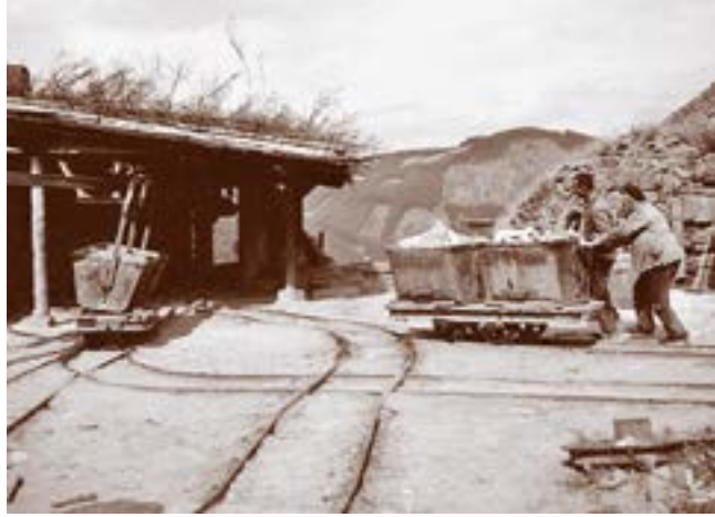
Abbildung 10: Aufgabe des Rohstoffs an der Seilbahn-Bergstation.
