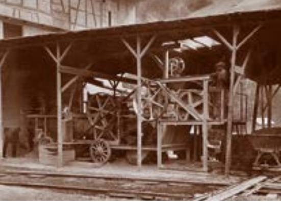
Abbildung 15: Erste semimobile Mischanlage des Hartsteinwerkes Mellenbach.
