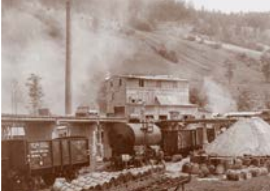
Abbildung 17: Das Bindemittel wird in Kesselwaggons angeliefert und danach in Fässer abgefüllt, gelagert und bevorratet. 1923 erfolgt der Neubau eines Schornsteins, der für den Betrieb der Dampfmaschine notwendig ist.
