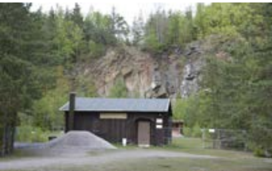
Abbildung 4: Obere Abbausohle des Mellenbacher Bruchs, gegenwärtige Nutzung als Schießanlage (Mai 2017, gleiche Aufnahmesituation wie in Abb. 2).
