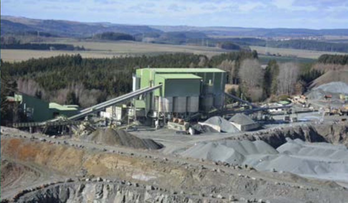
Abbildung 7: Vollständig eingebaute Aufbereitungsanlage des Steinbruchs Burgk.
