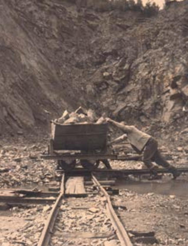
Abbildung 2: Das gesprengte Haufwerk wurde im Steinbruch per Hand in Loren verladen. Mit diesen wurde das Material zur Aufbereitungsanlage gefördert.
