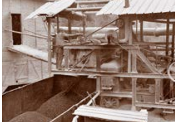
Abbildung 18: Verladung der Mischsplitte in Eisenbahnwaggons.
