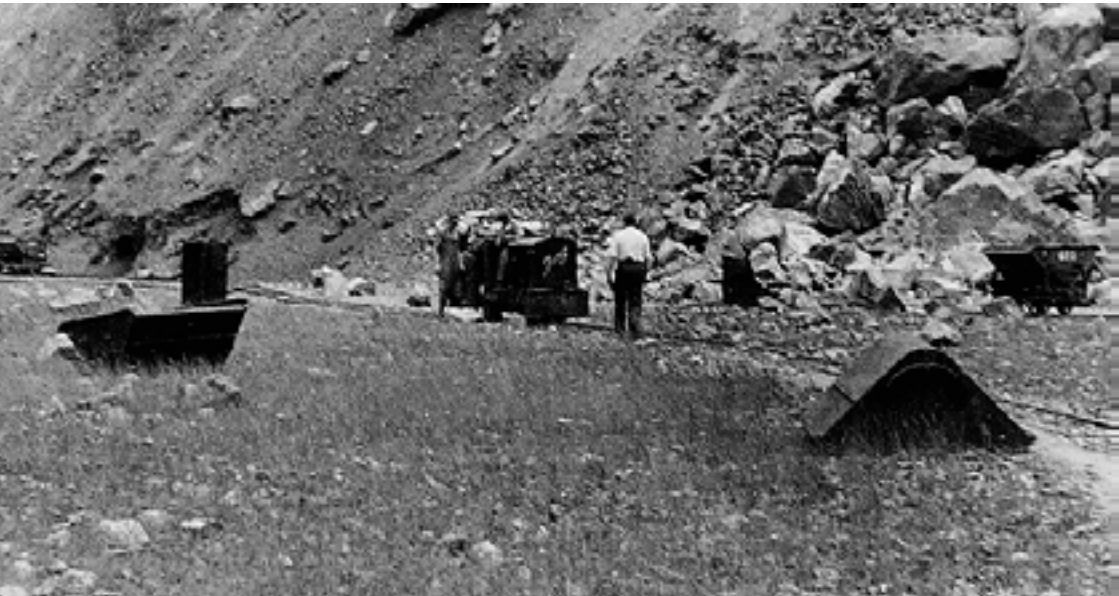
Abbildung 9: Handverladung des Haufwerks im Steinbruch.
