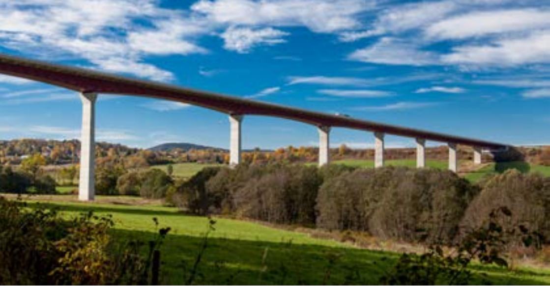
Abbildung 21: Reichenbachtalbrücke auf der A71 südlich von Ilmenau.
