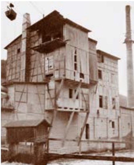
Abbildung 11: Talstation und Aufbereitungsanlage.
