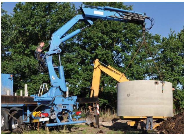
Bild 11: Einbau mit einem Versetzkran
