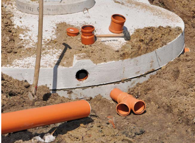
Bild 12: Verfüllung mit vorhandenem Bodenmaterial
