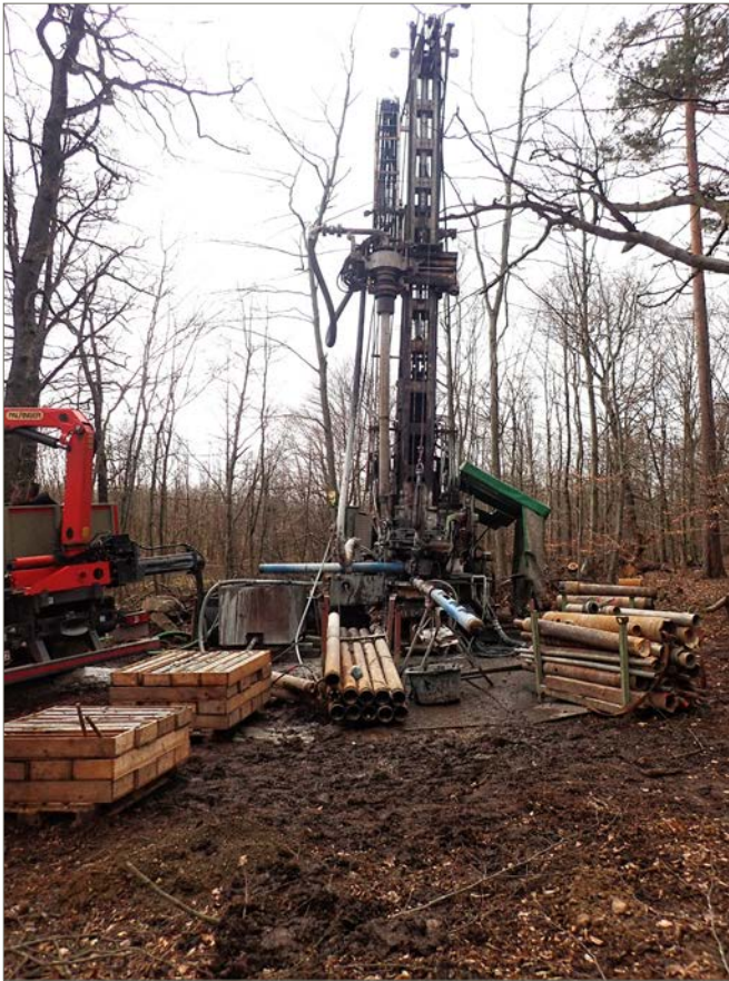
Abb. 3: Aufsuchungsarbeiten sind eine wichtige Voraussetzung für die zukünftige Sicherung der Rohstoffgewinnung
