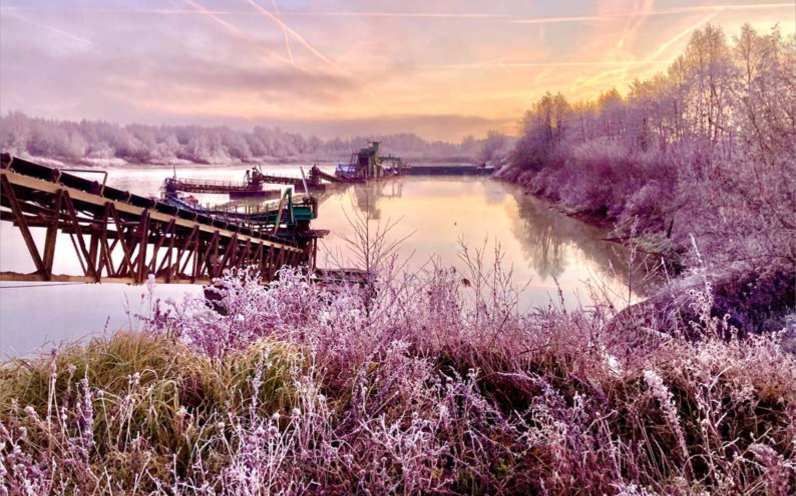
▲ 1. Platz: Winterstillleben am Schwimmbagger von Henrik Rumke.
