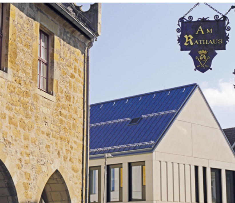
Urban Mining beim Neubau des Rathauses in Korbach.
