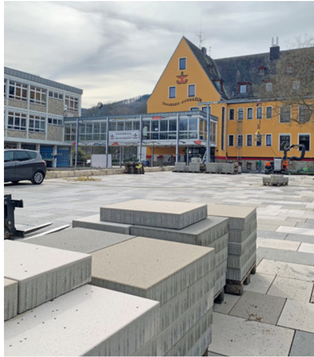
Auf dem Schulhof wird das Recyclingpflaster verlegt. Rein optisch besteht kein Unterschied zu konventionell gefertigtem Betonsteinpflaster.
