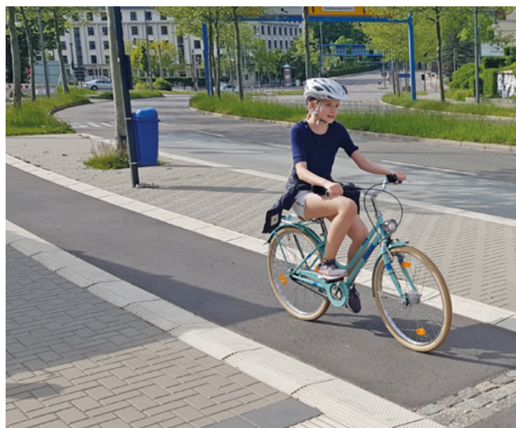
Bei gleichem Bodenniveau dient eine Radwegplatte als Begrenzungstreifen zur Trennung.
