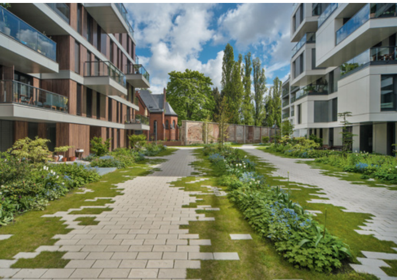
Entsiegelung in einem Wohngebiet.
