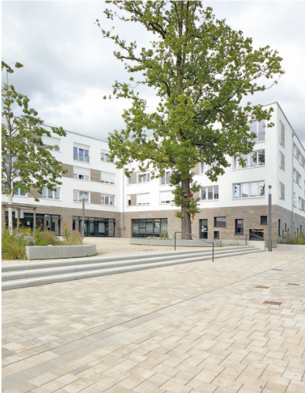
Versickerungsfähiges Pflaster rundet die „Ökosiedlung“ ab und ist Teil des Nachhaltigkeitskonzeptes.
