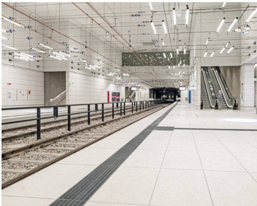
Großformatige Betonwerksteinplatten für stark beanspruchte Bereiche in der Karlsruher U-Bahn.
