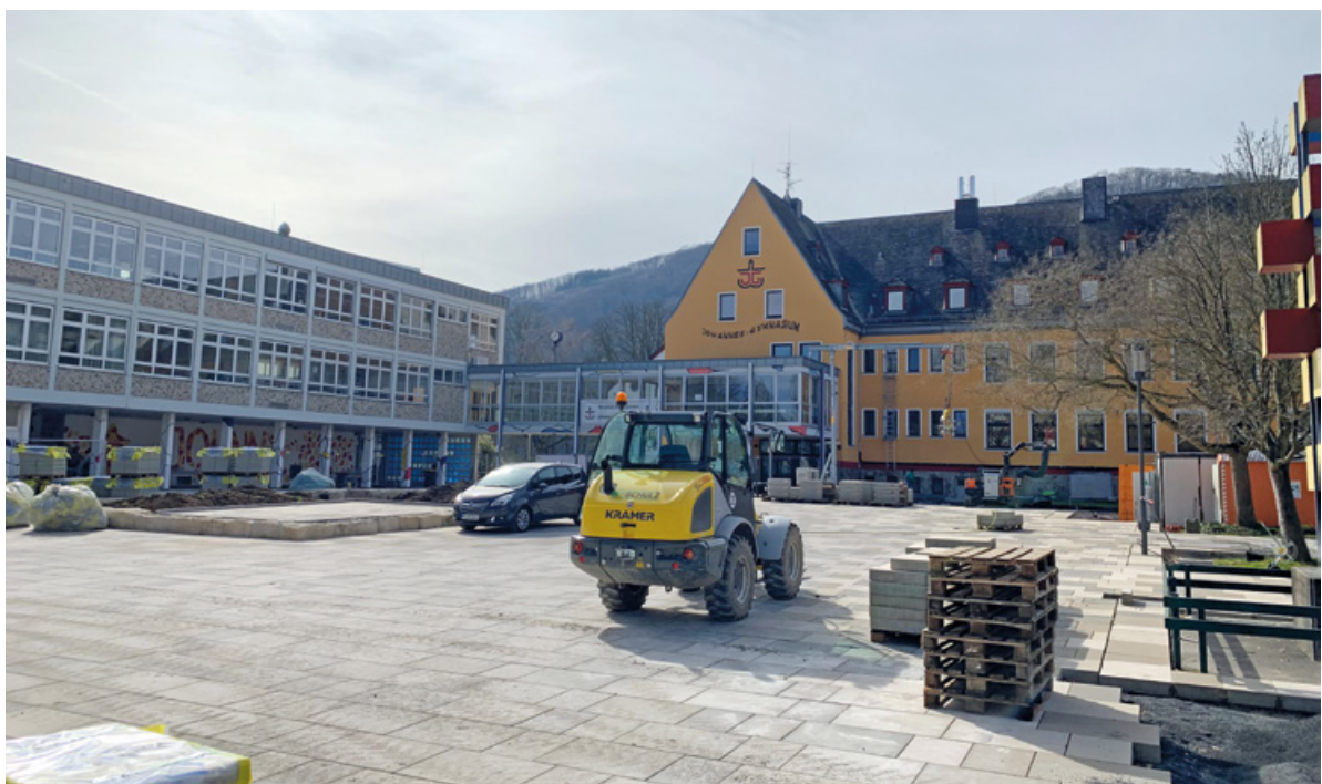
Das Recyclingpflaster wurde für die Schule in Lahnstein objektbezogen in der Farbstellung sandgrau mit fein gestrahlter Oberfläche gefertigt.
