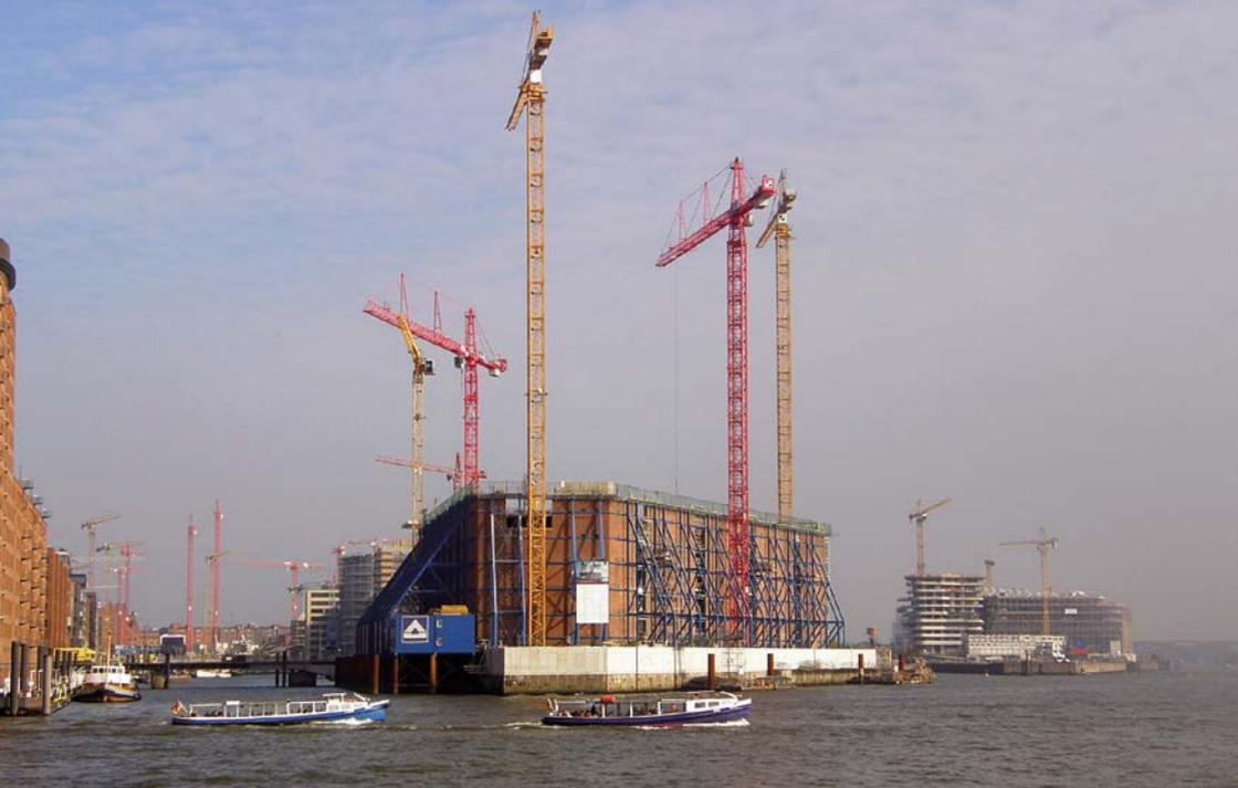
**Abbildung 1:** Die Baustelle der Elbphilharmonie in Hamburg im Oktober 2008. Allein für die Herstellung des verbauten 63.000 Kubikmeter Transportbetons (s. Text) wurden rund 41.000 Tonnen Bausand hoher Qualität benötigt (Foto: Emma7stern/Wikipedia).
