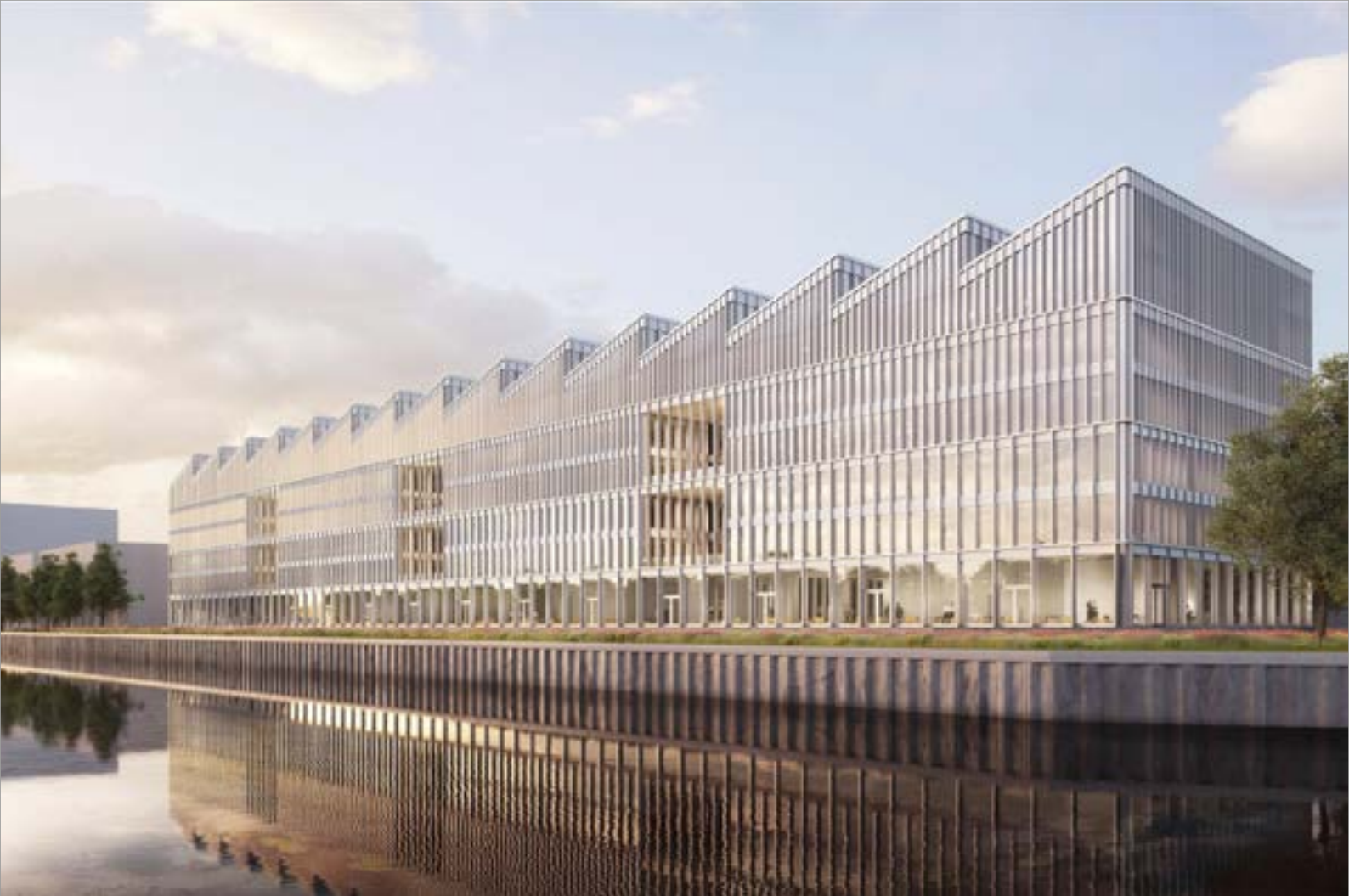
▲ Der Projektitel „SHED“ ist auf das Sheddach zurückzuführen. Diese Konstruktion, auch Sägezahndach genannt, lässt natürliches, blendfreies Licht einfallen und erinnert an ältere Industriegebäude und Fabriken. © Klingsöhr Unternehmensgruppe
