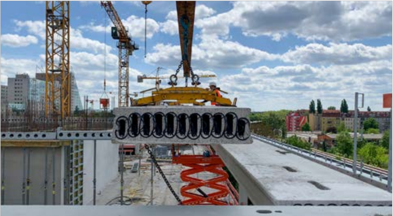
▲ Aufgrund ihrer Hohlräume benötigen die Spannbetonhohldecken 50 % weniger Beton als Ortbetondecken. © Mareike Albers /BATEG GmbH
