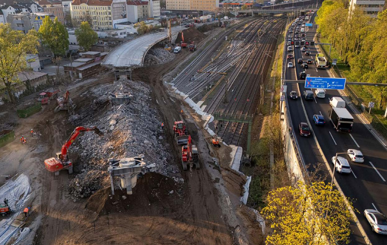
▲ Die Westendbrücke in Berlin-Charlottenburg ist eine der verkehrsreichsten Autobahnbrücken im Stadtgebiet. Der Abriss bedeutete auch eine Unterbrechung des Fern- und S-Bahnbetriebs (Foto: Jost Listemann).
