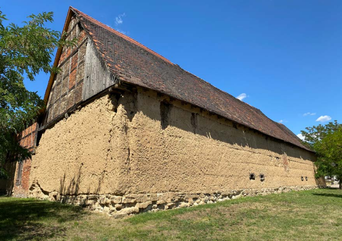
Abb. 7: Scheune des Vierseithofes östlich des Schlosses Dieskau, Saalekreis als Beispiel für die traditionelle Lehm-bauweise des Wellerlehmbaus in Mitteldeutschland (Quelle: GOLEHM, Landesamt für Denkmalpflege und Archäologie Sachsen-Anhalt).
