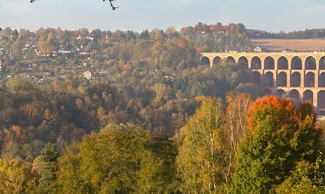
Abb. 3: Die Göltzschtalbrücke im Vogtland – mit 78 m Höhe und einer Länge von 574 m überspannt sie das Göltzschtal bei Netzschau. Erbaut zwischen 1846 und 1851 ist sie die größte Ziegelbrücke der Welt. Mit den regional vorhandenen Ressourcen waren Ziegel für den Bau der Brücke mit Abstand der kostengünstigste und ein schnell zu beschaffender Baustoff (Foto: Stephanie Wittwer).
