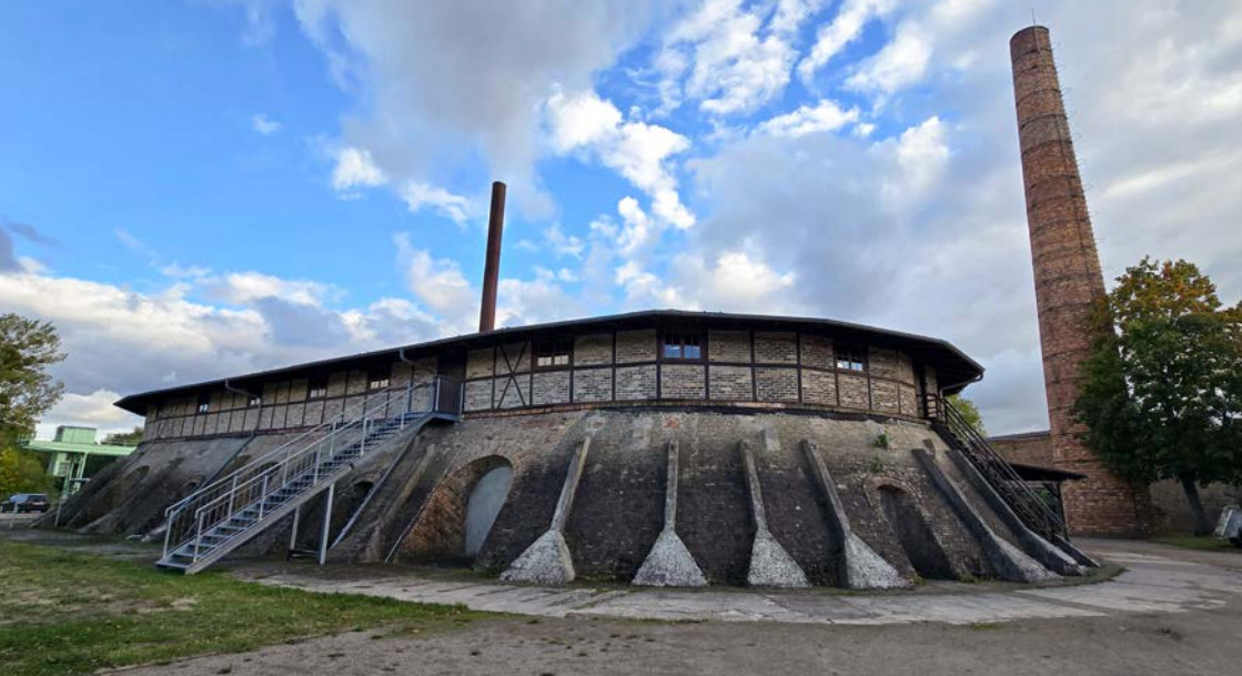
Abb. 1: Der Hoffmann'sche Ringofen ist Zeugnis der industriellen Entwicklung und revolutionierte die Ziegelproduktion. Mit ihm stiegen nicht nur die Produktionszahlen, sondern auch die Qualität der Ziegel. Der hier abgebildete Ofen steht im Ziegeleipark Mildenberg. Mit diesem und weiteren Öfen in der Region wurde Berlin mit Ziegeln versorgt (Foto: Regina Devrient).
