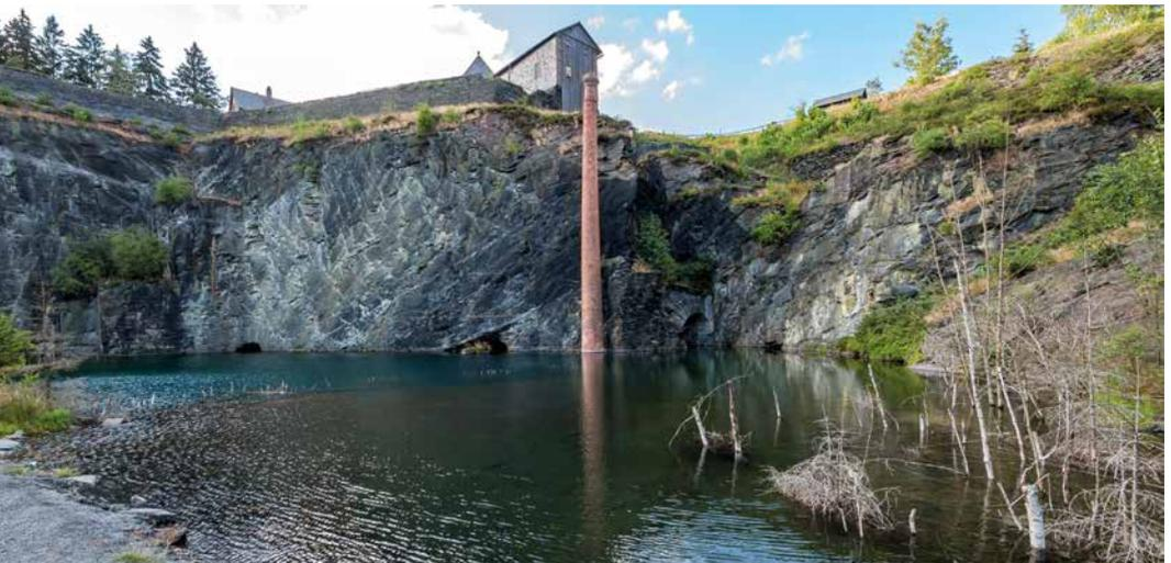
**Abbildung 1:** Staatsbruch Lehesten. Das Ensemble aus Historischer Göpelschachtanlage mit Entwässerungsschacht, Schornstein für die zur Entwässerung betriebene Dampfmaschine, dem gefluteten Tagebau und handgeschrägte Schieferbruchwände sind als Nationaler Geotop ein „Schaufenster in die Erdgeschichte“ (Foto: NoRud 2015).
